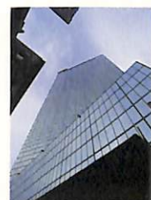
ジョン・ハンコック・タワー(1975) 空を取り込むカーテンウォール
