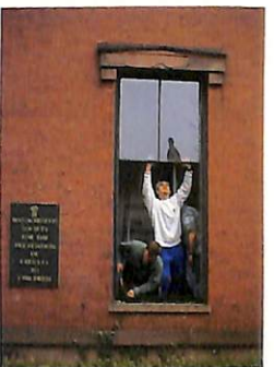
上3点共：ロウハウスにとって、窓は外観を演出する重要な役目。ピーコン・ヒルにて 下：窓を補修している現場に出会った
