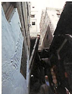
覗き込みを防止するために道路側の窓は高い位置につけられている
