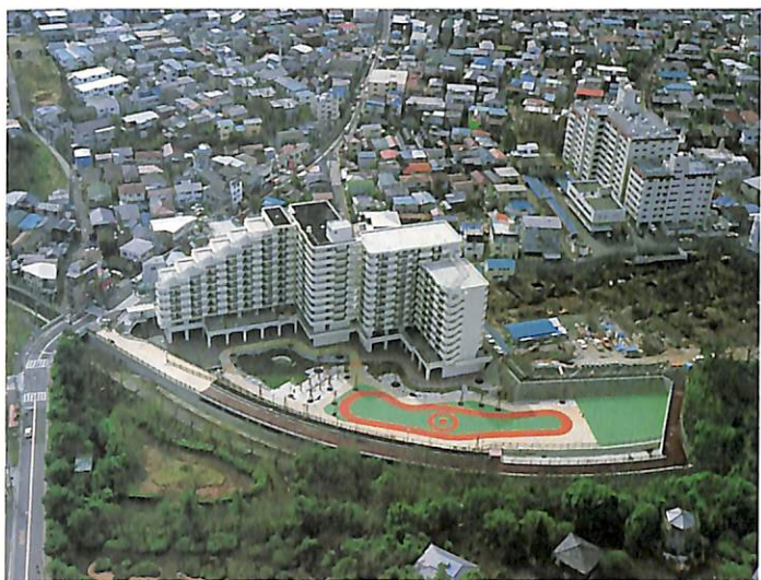
調整池は、豪雨による洪水を防ぐため、護 岸の一部に設けた越流堤から水を池内に流 入させ、公園や住宅のビロティ(高床)部 分に貯留させるシステム。⑨：中野区妙正 寺川第一調整池周辺の地図。⑩：その空撮 写真。資料提供：東京都建設局河川部
